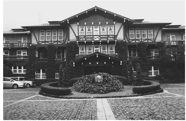
写真2：雲仙観光ホテルの外観
