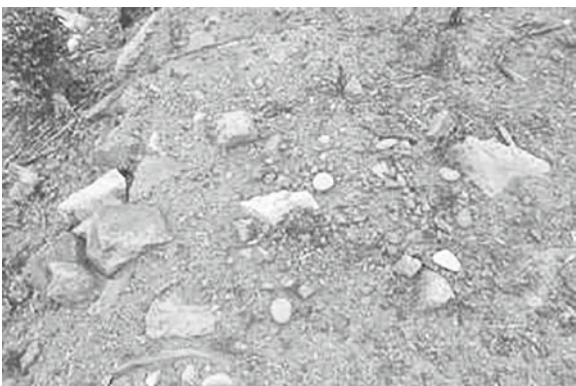
仮No.6 9 南から
