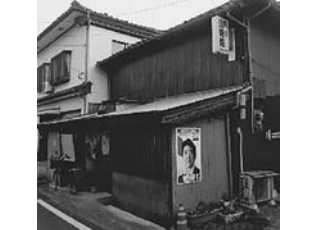
山崎屋の外観
